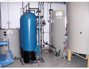
Das anfallende Abwassser wird bei einer Chargenanlage entsprechend einer Behandlungstechnologie in einzelnen Teilschritten behandelt.
